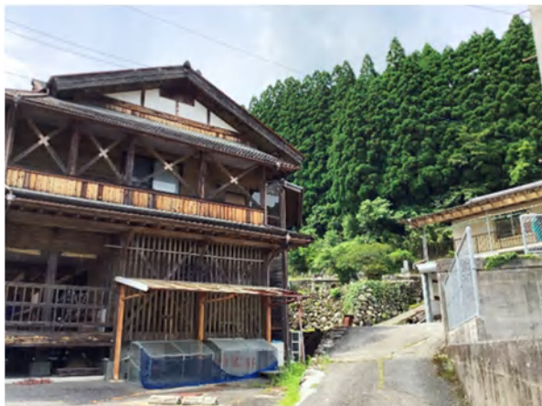
【東峰村災害伝承館】
