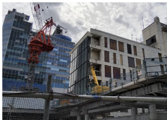
渋谷駅改修工事 資材搬入口
