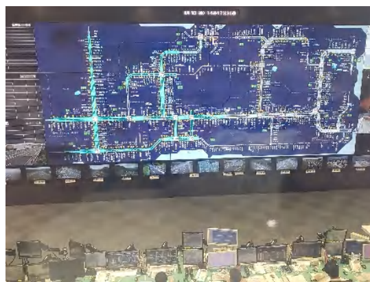
道路管制センター(交通管制室)
