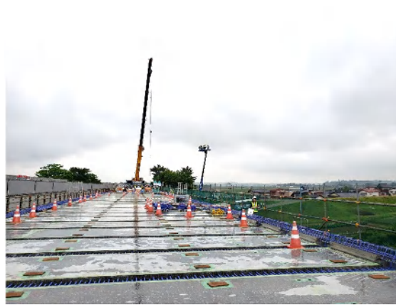
PC床版架設状況
