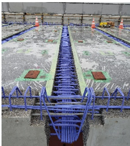
PC床版間詰め部
