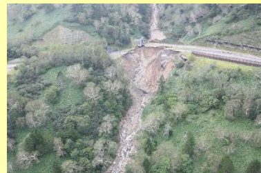
国道 274 号日勝峠の復旧工事の様子 (北海道開発局帯広開発建設部ウェブサイトより)
