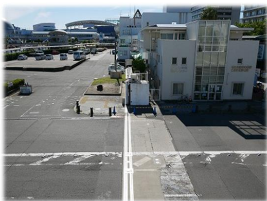
防潮扉 (写真中央の縦線上を扉が閉まります)
