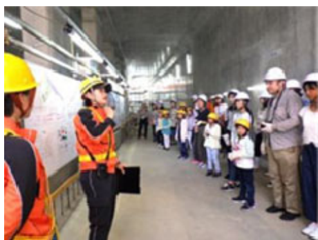
過去の様子①工事中のトンネル内部見学
