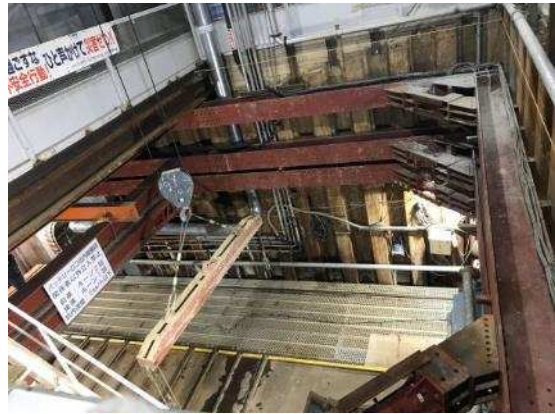
坑口は道路直下のため、荷卸し後に横引きします
