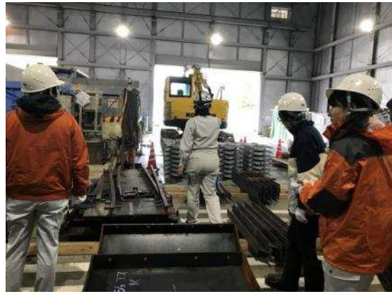
セグメントや坑内設備のストック
