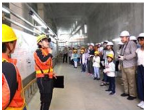
昨年の様子①工事中のトンネル内部を見学
