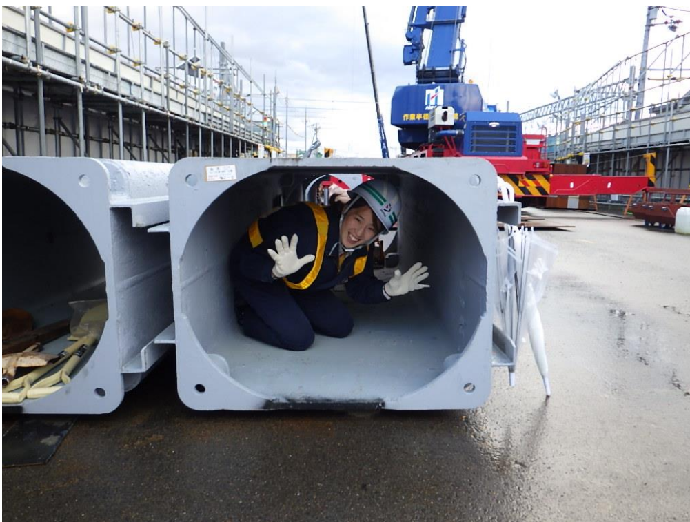
箱型ルーフ：実際にこの中に人が入って掘削を行います。
