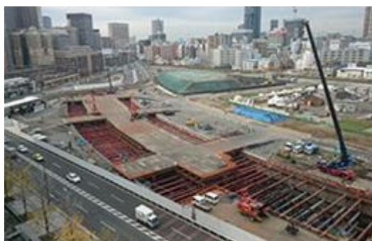
(2018年4月頃の工事現場の様子)
