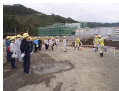
大ケロ右岸(源水大橋)現場
