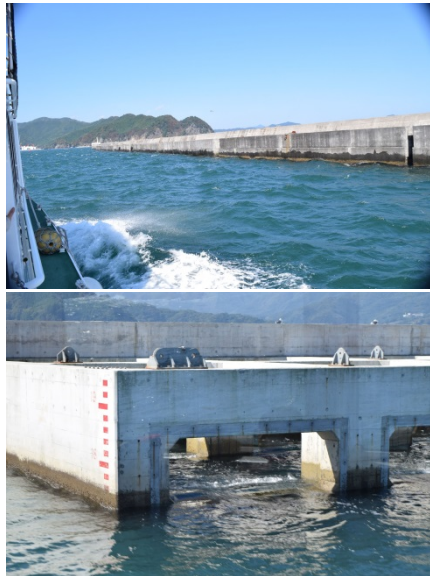
設置済みのケーソンと防波堤
