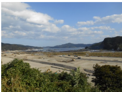
ストックパイル現場
