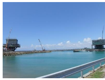
柱頭部施工状況
