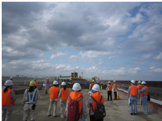
CSG工法の敷均し状況
