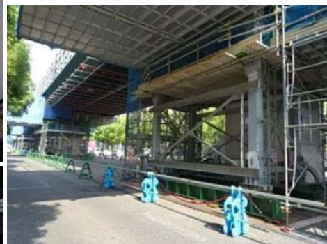
地下鉄の近接状況や支保工の様子
