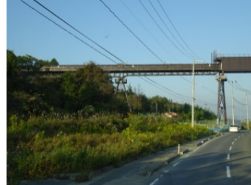
東松島市防災集団移転促進事業:(上)(下)土砂運搬用ベルトコンベヤ
