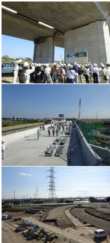
仙塩道路拡幅事業:(上)新設の道路橋の下で説明を受けました/(中)こちらの区間では土木工事はほぼ終了/(下)軽量盛土を利用すると法分だけ必要用地が小さくなります
