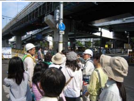
線拡幅部の支保工の様子 説明を受けています
