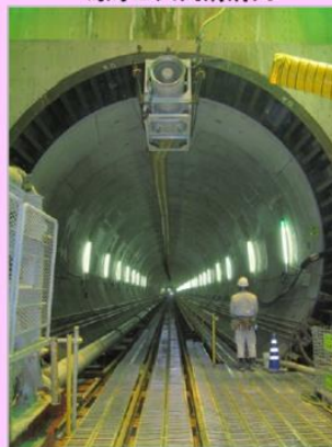
なるみ 鳴海Ⅲ共同溝溝内
