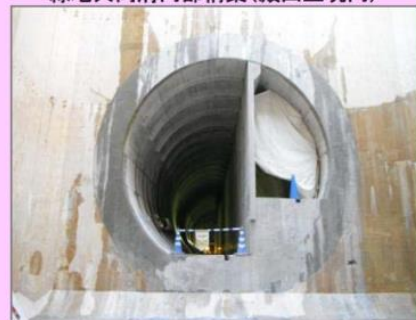
緑地共同溝内部構築(殿山立坑内)
