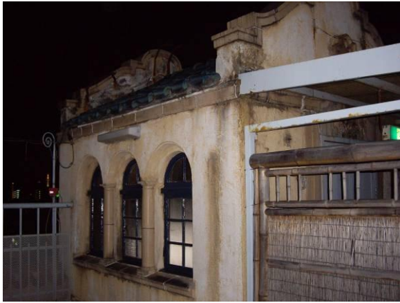
・屋上にある従業員用階段の屋根
