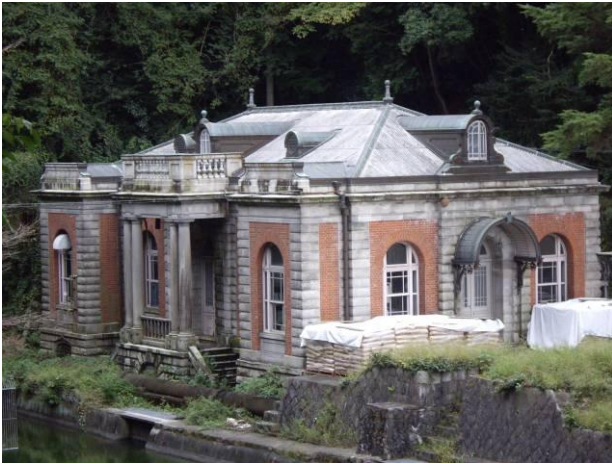
・旧九条山浄水場ポンプ室（旧御所水道）
