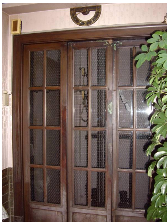
・1階エレベーター
