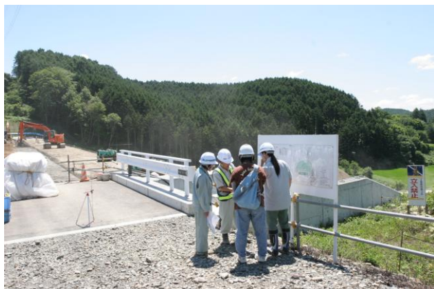
工事概要を説明していただきました。
