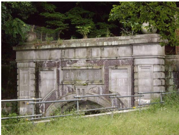
・琵琶湖疏水のトンネル坑口のうちのひとつ
