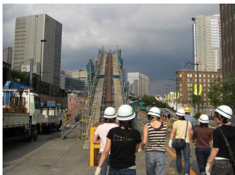
*軌道用の鋼材を挿入するための架台*
