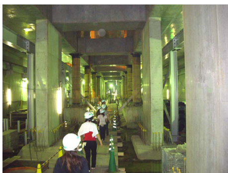
*駅舎部 プラットホームを見学*
