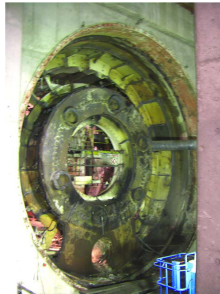
*到達したシールドマシンを解体中*
