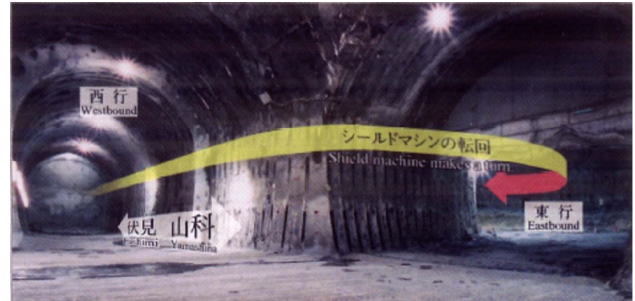
図-2 シールドマシン転回部
