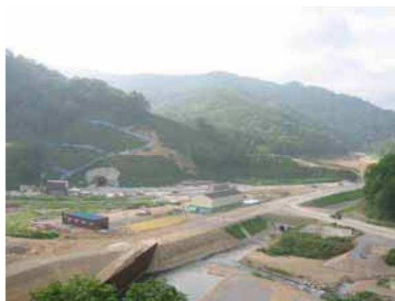
現場の様子（完成時右半分は水の中になってしまうそうです）
