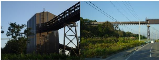
土砂運搬用ベルトコンベヤ
